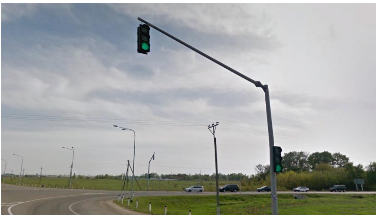
Рисунок 1.7.1 – Пример эксплуатационного состояния светофора, расположенного пересечении а/д 00 ОП ФЗ А-160 «Майкоп - Бжедугхабль - Адыгейск - Усть-Лабинск – Кореновск» и а/д 03 ОП РЗ 03К-037 «г. Белореченск- ст. Гиагинская»
