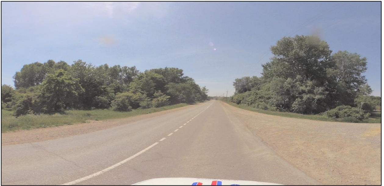
Рисунок 1.4.6 – Состояние дорожного покрытия а/д 03 208 ОП МР 06 «п. Южный-Химзавод» на момент обследования
