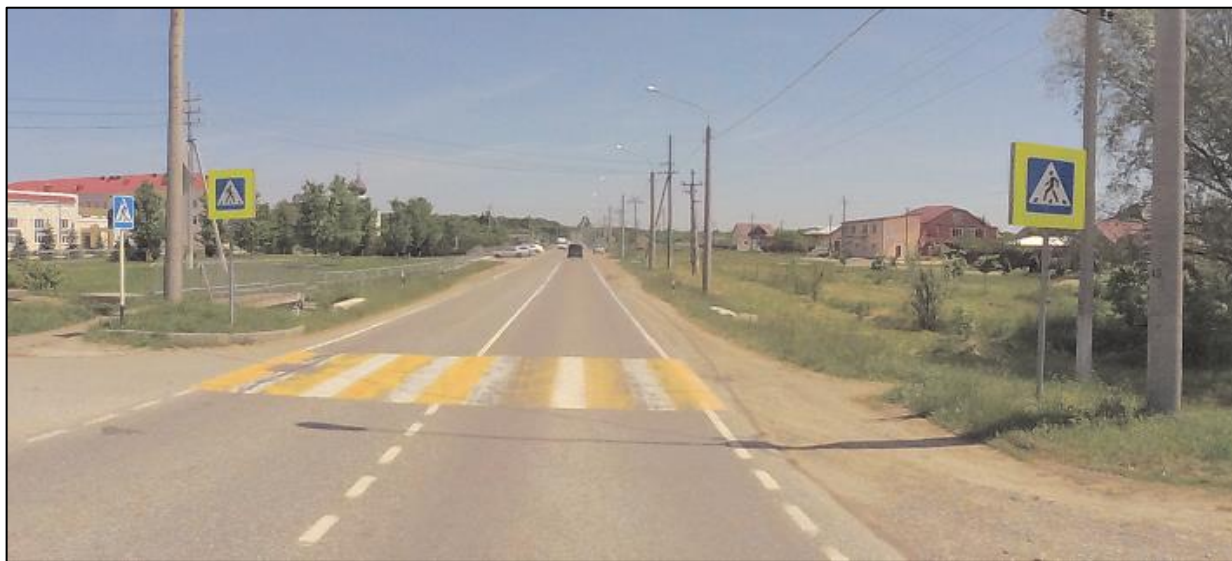
Рисунок 1.7.2 – Пример эксплуатационного состояния ТСООД, расположенных на территории МО Белореченский район (а/д 03 208 ОП МР 10 «Подъезд к п. Родники» (пересечение ул. Норильской – пер. Школьный))
