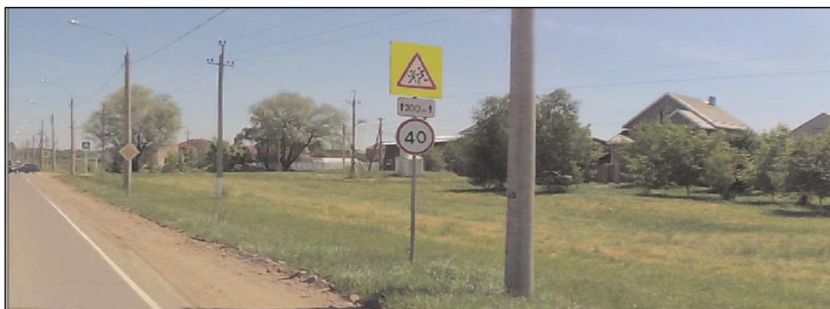
Рисунок 1.7.3 – Пример эксплуатационного состояния ТСООД, расположенных на территории МО Белореченский район (а/д 03 208 ОП МР 10 «Подъезд к п. Родники» (пересечение ул. Норильской – ул. Школьной))
